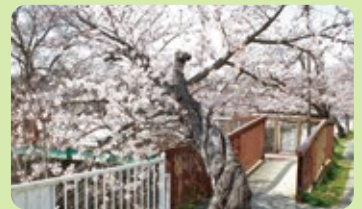
8 妙法寺川公園 妙法寺川公園歩道橋
