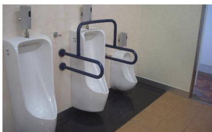
トイレのユニバーサルデザイン対応（神戸総合運動公園）
