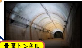
青葉トンネル
